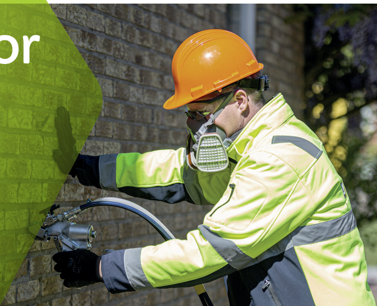
Isolatie van spouwmuur
